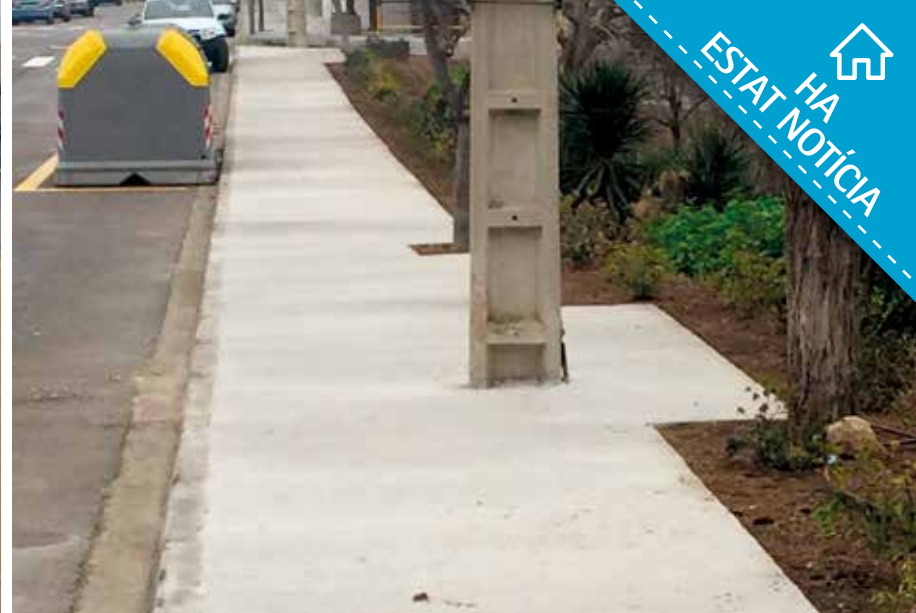
Nova pavimentació del carrer del Pilar
