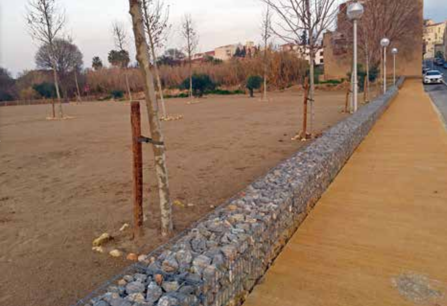
Obra a l'aparcament del Camí Vell de Reus
