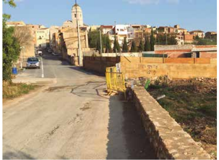
Els murs de pedra seca del Camí vell de Reus consolidats
