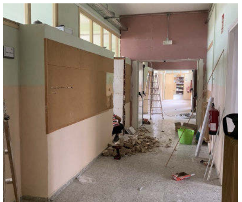
Imatges recents de les obres que s'estan duent a terme al llarg d'aquest estiu a les instal·lacions educatives. FOTO: MERCÈ VECIANA
