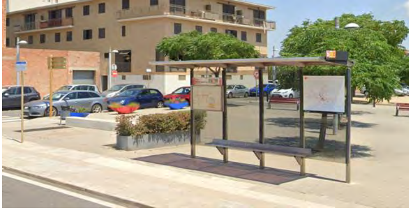
Parada de bus de Pau Vidal amb marquesina
