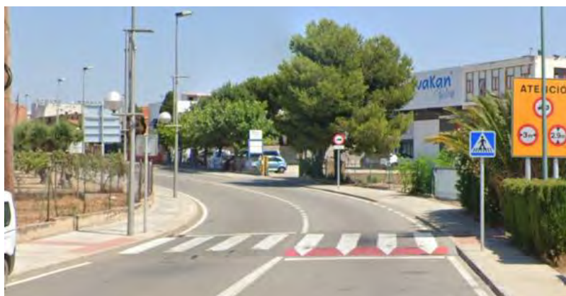
Pas de vianants elevat de l'Av. de la Pineda
