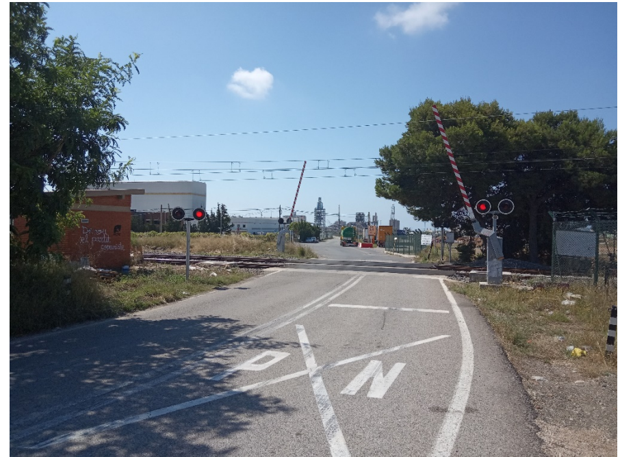
10. PASO A NIVEL CLASSIFICACIÓ-CAMÍ DE L'APEADERO
